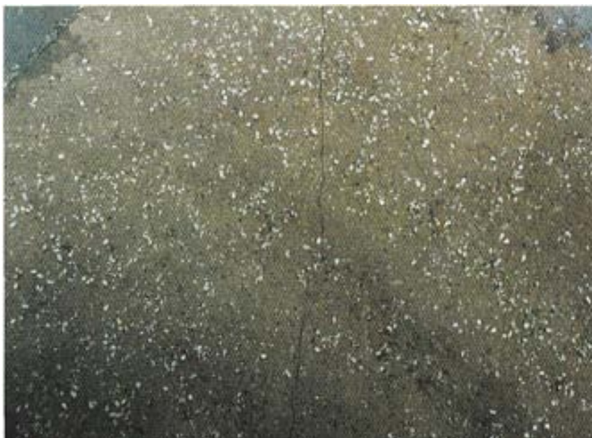
Figur 2. Revner i tagpap foranlediget af isspændinger.
